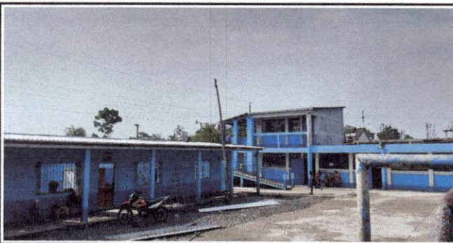
Foto 5: Panorámica de cambio de techo de las 3 aulas
