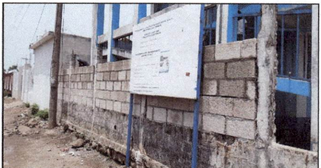
Foto 6: En proceso de reparación del muro perimetral
