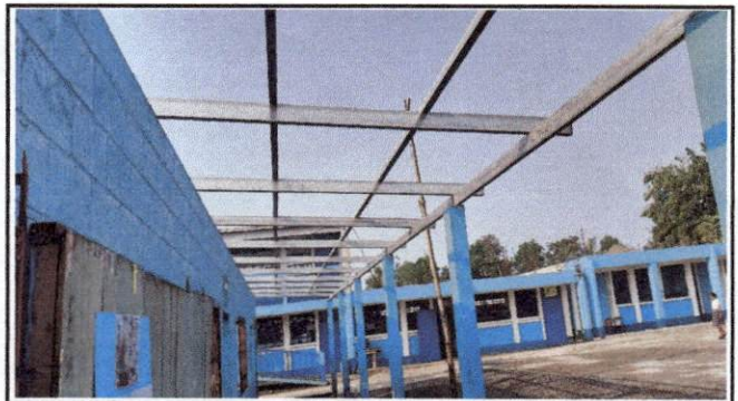
Foto 4: Cambio de estructura de madera por metal del corredor de aulas.
